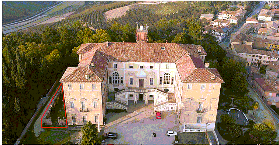
Il castello reale di Govone è un'ex-residenza sabauda che domina il paese: a sinistra, nell'area evidenziata di rosso, il muro oggetto del contendere
